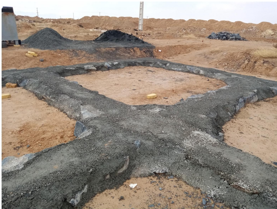
توضیح تصویر: یک نمونه اجرای سنگ چینی زیر پی (لاشه چینی) همراه با ملات سیمانی کم عیار، در شمال غربی شهرک
